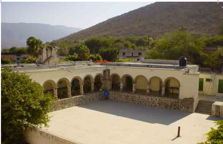
130 Arcada del patio interior de la casa conventual, hoy delegación municipal; destaca el desplante de los arcos que es sumamente bajo, motivado por la talla de las niñas indígenas.
