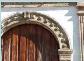
59 Detalle del arco de la portada principal de la iglesia de San Sebastián el Grande; destaca la simulación de las perlas isabelinas en las dovelas del arco.
