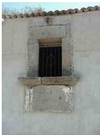
131 Detalle de jamba de ventana de las habitaciones de las niñas; destaca la presencia de algunos elementos monolíticos en su construcción.
