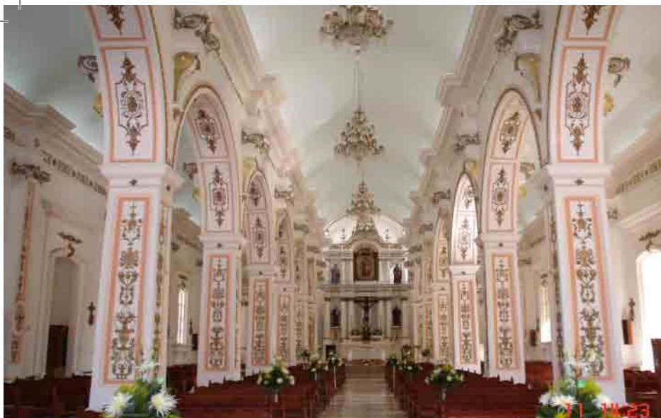
79 Aspecto espacial del interior de la iglesia de San Antonio, con bóveda de cañón corrido en la nave central.
